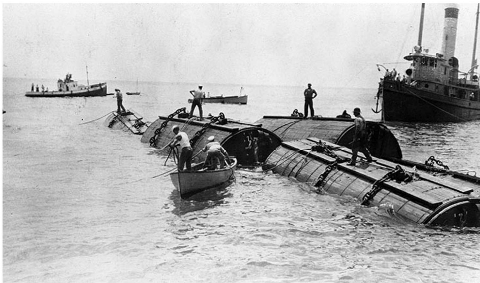
F-4 hænger i kæderne under løftepontonerne (NH 74732 courtesy of the Naval History & Heritage Command)
