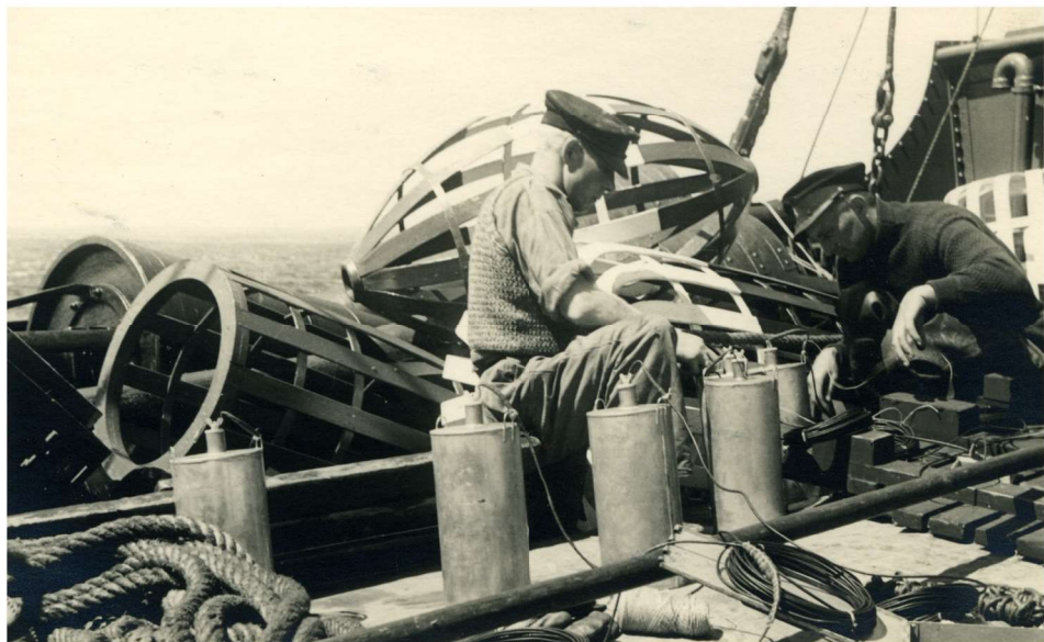
Karl Poul Jensen og C. E. Jørgensen er ved at klargøre sprængladninger. (Ladningerne er de såkaldte sprængbøsser fremstillet af Ammunitionsarsenalet i Elling og ladet med TNT. Red. Finn Linnemann)
