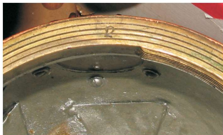
Indgravningen i hjelmens øverste flange er placeret over de riller, som skal forhindre læderpakningen i at blive presset ud.
