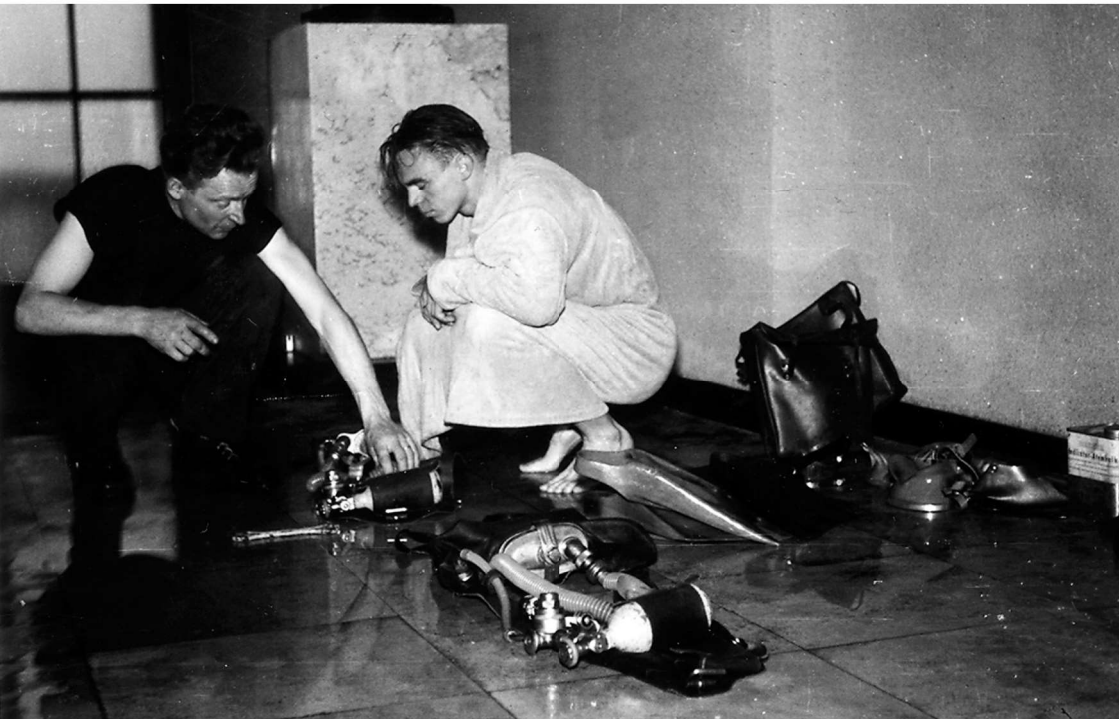
Jan Uhre og Kurt Worsø ved iltapparater model 138 fra Drägerwerk. Apparaterne, der blev anvendt til undervisning af Brandvæsenets og Falcks reddere var Jan Uhres. Billedet er fra 1956.
