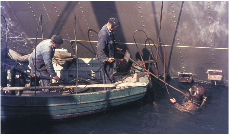
Nikkepumpe i brug på Nakskov Skibsværft i forbindelse af rensning af minelæggeren Sjælland for løbetømmer efter stabelafløbningen den 14. jun i 1963. Da Nakskov Skibsværft lukkede, blev pumpen overdraget til Nakskov Marineforening, som senere har doneret pumpen til selskabet.
