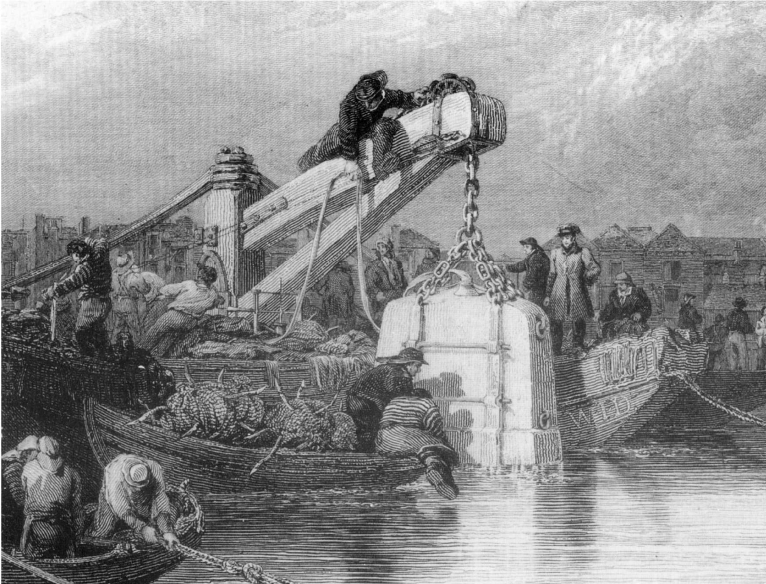
Anvendelse af luftforsynet dykkerklokke ved undersøgelse af kollaps af Themsen Tunnellen 18. maj 1827. Bemærk den 1-cylindrede nikkepumpe umiddelbart ved siden af kranen. (Stik af George Cook's efter Clarkson Stanfield tegning. Fra John Bevan: The Infernal Diver)
