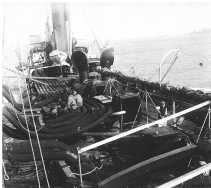
Protector med pumpe­slanger lagt ud til en havarist. Pumpekapaciteten var 4.000 l i minuttet.
