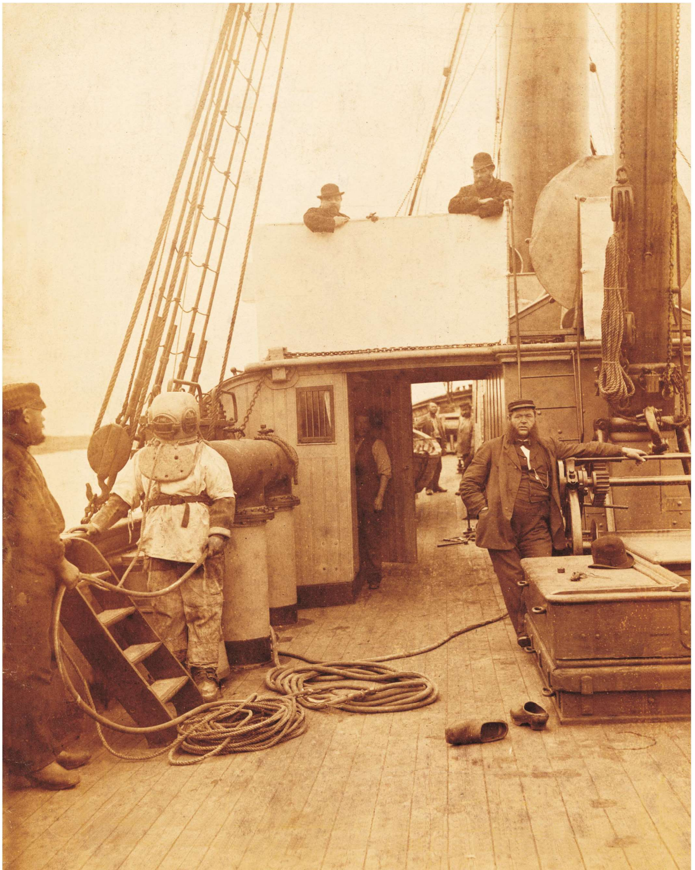
Det gamle billede. Bemærk dykkerens træsko og bowlerhat, der ligger smidt på dækket samt slangen der er slidt gennem kanvasset og er samlet på midten over en stuts.
