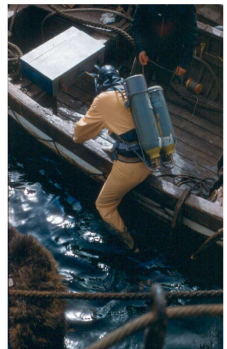
Svømmedykker på vej i vandet med AGA trykluftapparat for at fjerne spandekæden fra gravemaskinen
