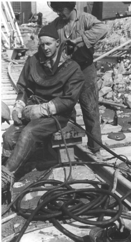
Brystringen monteres inden dykning i Ivigtut, Grønland
