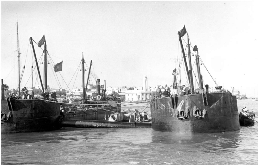
Løftepontonerne Thor og Odin med gravemaskinen imellem sig
