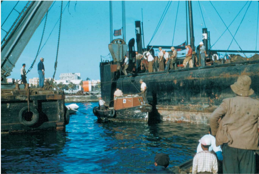
Arbejdet er fuldført, og Eir tages ombord på en af hævepontonerne
