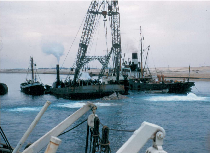
Vrag nr. 23 rulles op på ret køl af flydekranen Condor samtidig med at hævecylinderne Knold og Tot blæses tomme for vand
