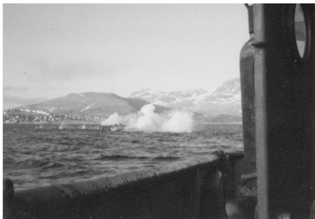
Kablerne søges sprængt så vraget slipper pontonerne
