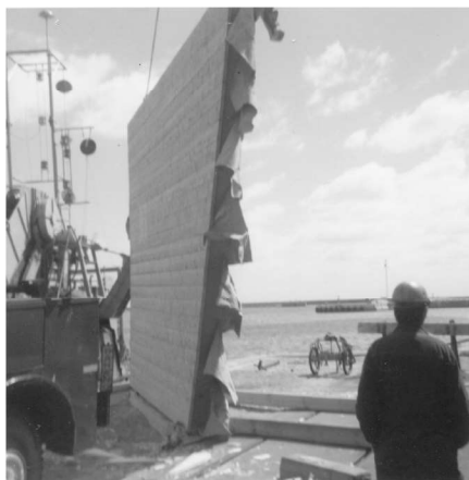
En platform er klar til at blive monteret over lækagen
