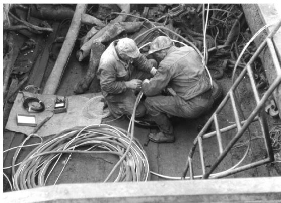
Kommunikationskablet reparereres
