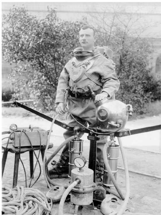
Vort hollandske medlem David Dekker har sendt os dette kopi af et gammel postkort visende en dykker i et Franz Clouth udstyr tilsvarende det, som har været anvendt i Undine. Læg mærke til at hjelmen har 2 lufttilslutninger.
