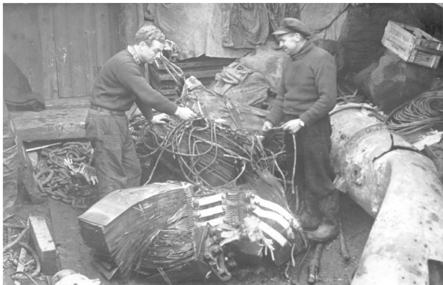
Akkumulatorer og torpedorør fra en ubåd. Til venstre ses Harry og til højre skipper Otto Olsen. Dobbeltcellen i midten vejer 320 kg.
