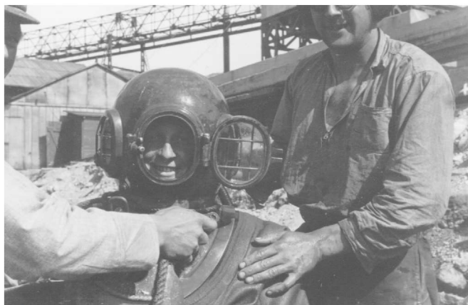
2-bolts-hjelme fremstillet ved Siebe Gormann, blev bl.a. anvendt ved dæmningsarbejde i kryolotminen i Ivigtut under 2. verdenskrig.
