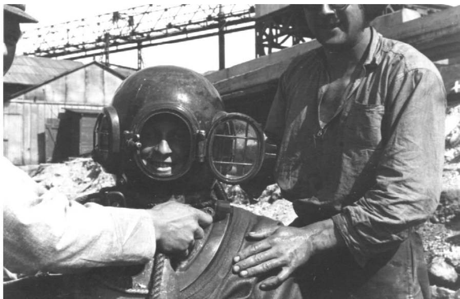
Der blev bl.a. anvendt engelsk fremstillede 2-bolthjelme (Hansens Patent)
