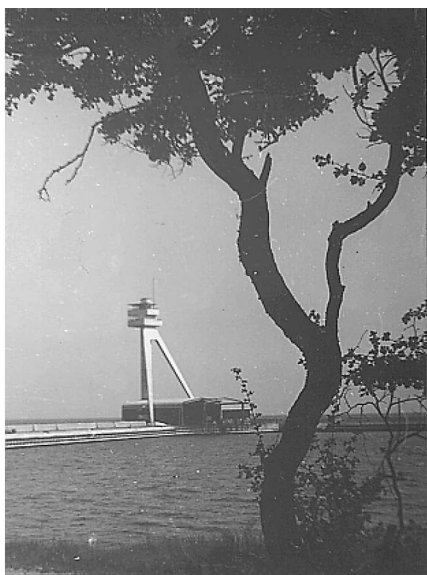
Det 3-benede kontrolltårn på Kongsøre Næs
